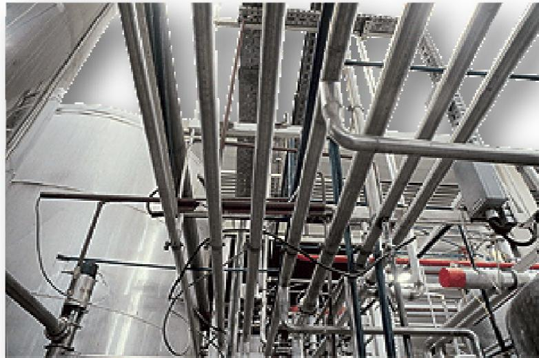
Cevovodite se izrabortuvaat od ne'rgosuvacki austenit ( CrNi ) celici so TIG zavaruvanje vo atmosfera na Ar i zastita od vnatresnata strana na cevkite.Spojnite elementi kako i cevnata armatura se od asortimanot na Electrolux PALENZO - INOX.
