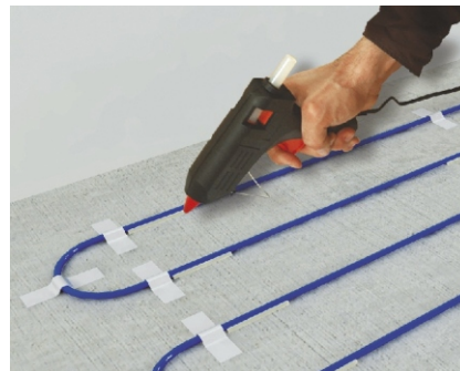
Pričvršćivanje grijaćeg kabela pomoću vrućeg ljepila.
