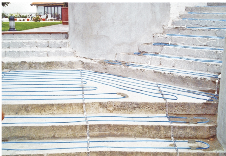
Postavljanje grijaćih kabela
