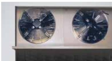
Der Isolierkühler besteht aus der Isolierzelle, dem Kühlerblock, den zugeordneten Ventilatoren, der Verschlussklappe für die Abtauphase und für Wartungsarbeiten, einer oder zwei Zugangstüren und wahlweise einem angebauten Schaltschrank.
